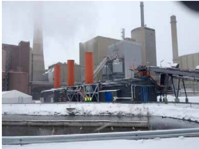
Kuva: Metso Oyj. Etualalla biomassan kuivaamo (punaiset piiput) ja kaasutuslaitos. Taustalla Vaskiluodon Voiman voimalaitos.
